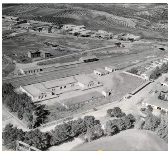
*Almacén regulador de Torredonjimeno (Jaén). Fuente: Patrimonio Comunal Olivarero.
