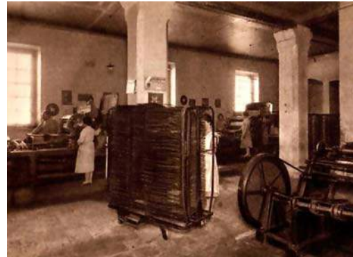
*Factoría de Cabra . Litografía, sala de máquinas. Archivo fotográfico de Hecoliva. S.A.
